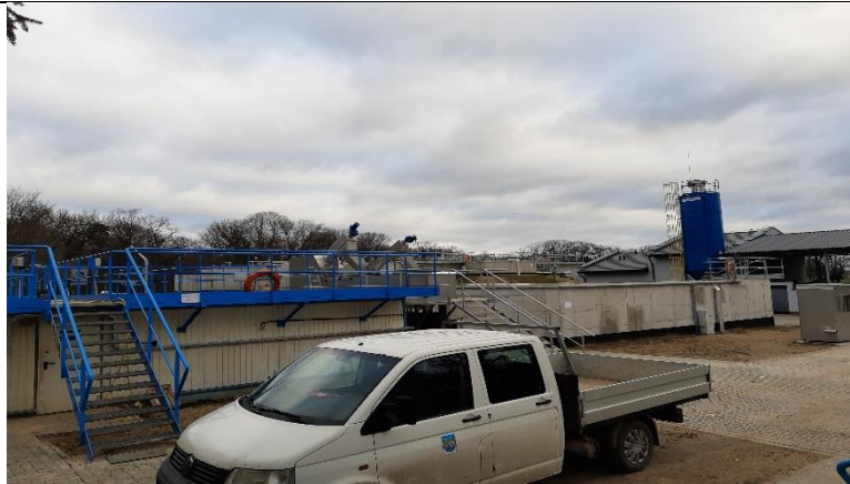
a) Modernizacja i rozbudowa gminnej oczyszczalni ścieków w Trzebiechowie
