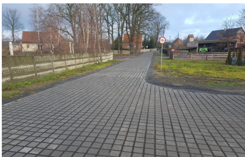
a) Remont drogi gminnej w sołectwie Głuchów – etap II
