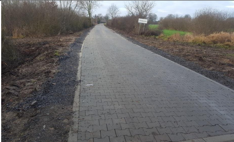
b) Remont drogi gminnej w sołectwie Głęboka
