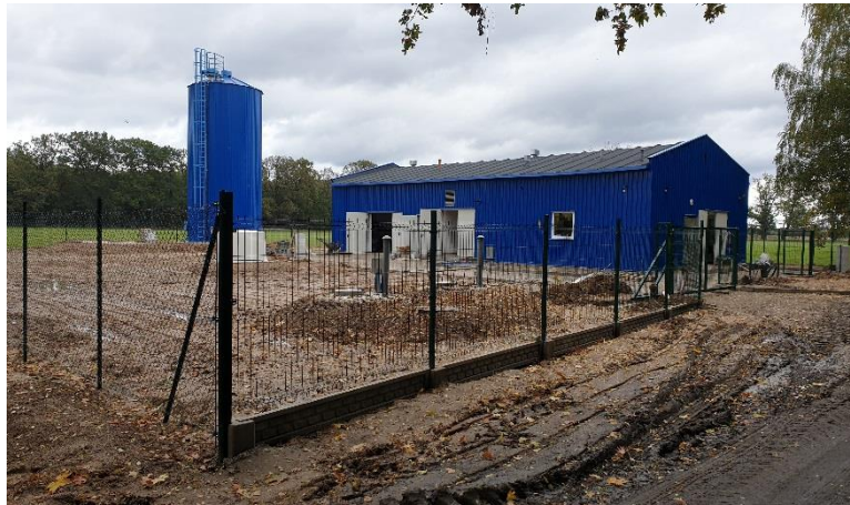
b) Przebudowa ujęcia i stacji uzdatnia wody w Trzebiechowie
