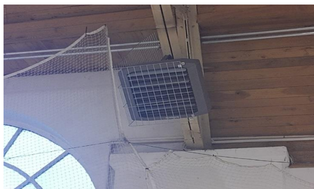
b) Montaż nagrzewnic w sali sportowej w Trzebiechowie
