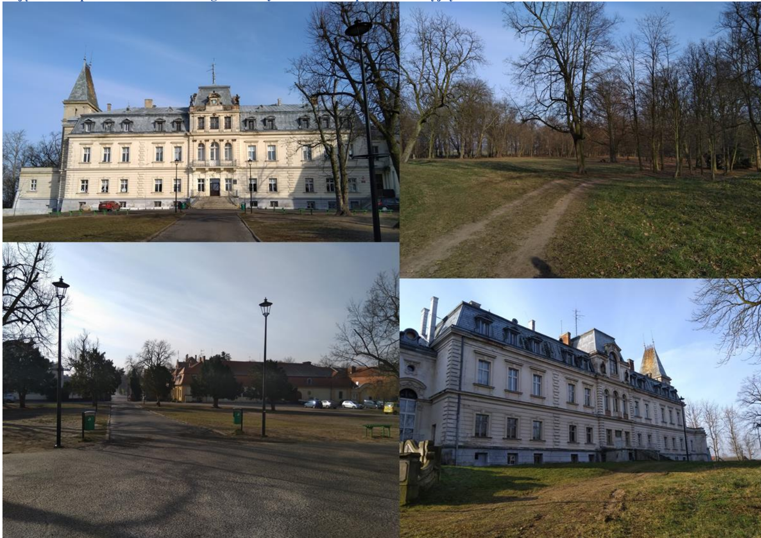
Zdjęcie 9 Rozpoznanie obszarów zdegradowanych w ramach spacerów studyjnych - Trzebiechów
