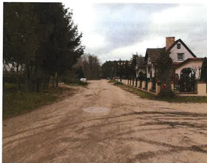
Przebudowa ul. Nowej w Trzebiechowie
