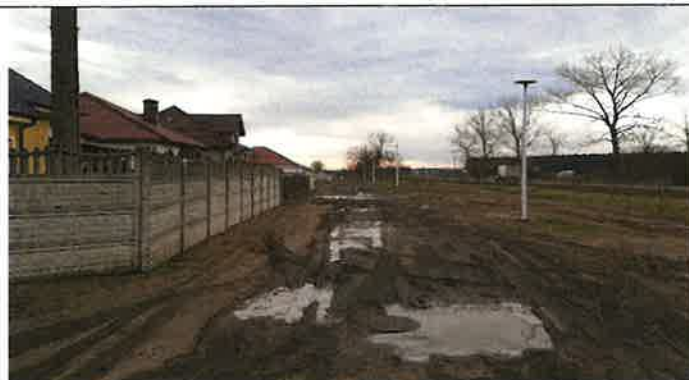
Budowa kanalizacji sanitarnej ul. Skowronkowa w Trzebiechowie
