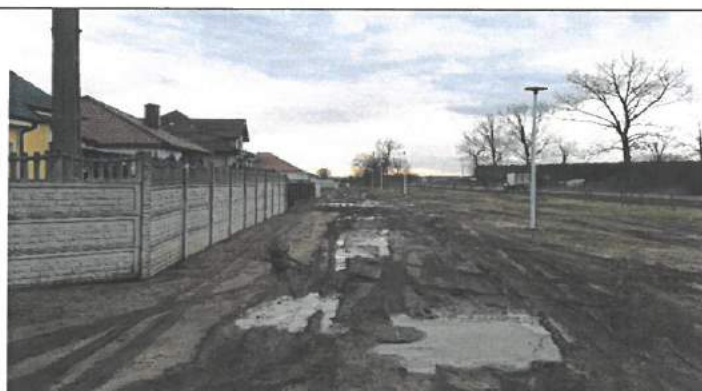
Budowa kanalizacji sanitarnej ul. Skowronkowa w Trzebiechowie
