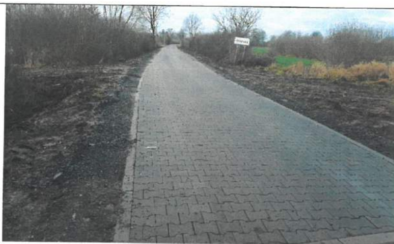
b) Remont drogi gminnej w sołectwie Głęboka
